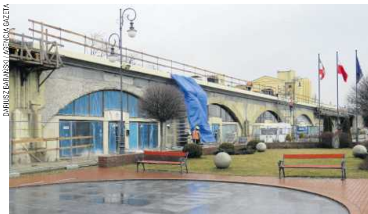
Nisze zamknięto ze względu na remont estakady
